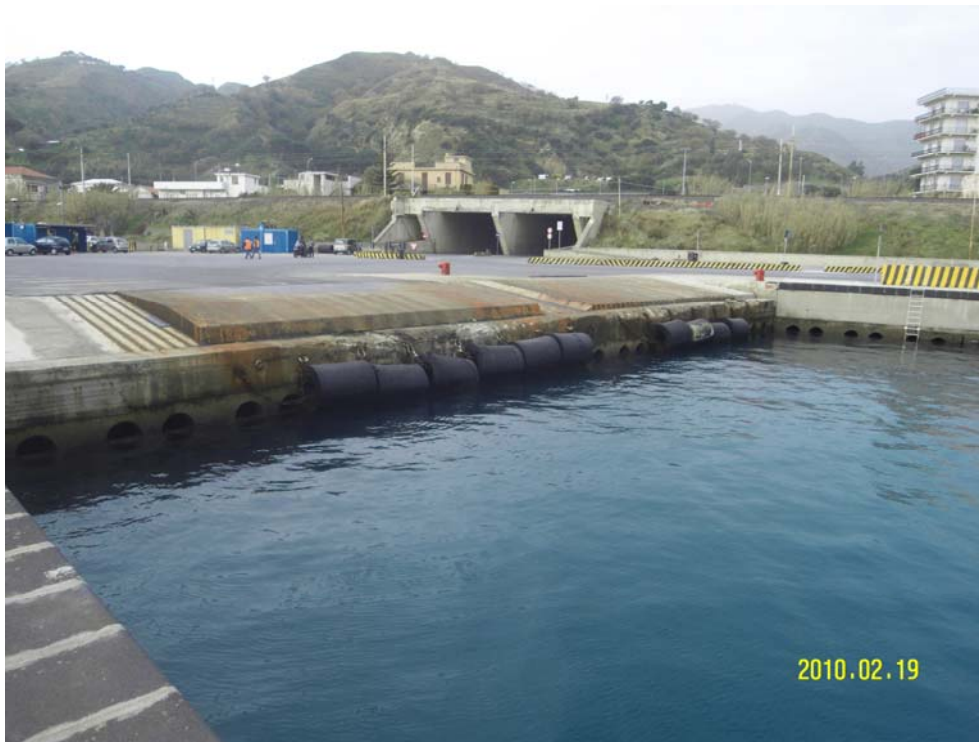
Fotografia dell'area di intervento 1
