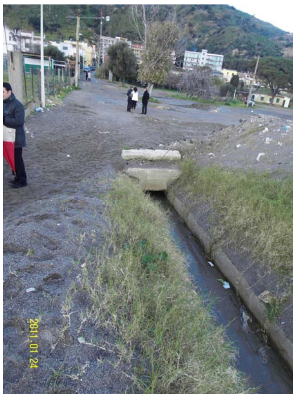
Fotografia dell'area di intervento 14
