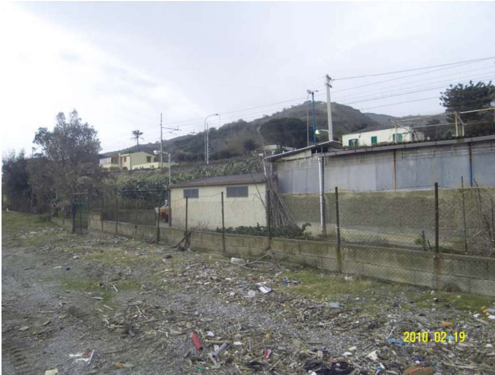
Fotografia dell'area di intervento 5
