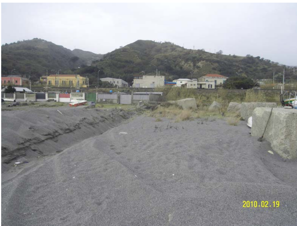
Fotografia dell'area di intervento 3
