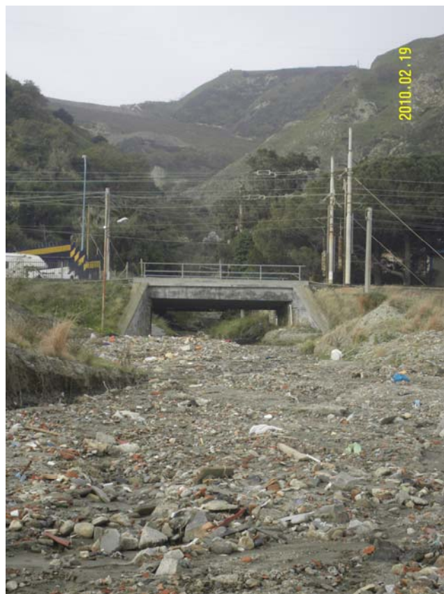
Fotografia dell'area di intervento 8
