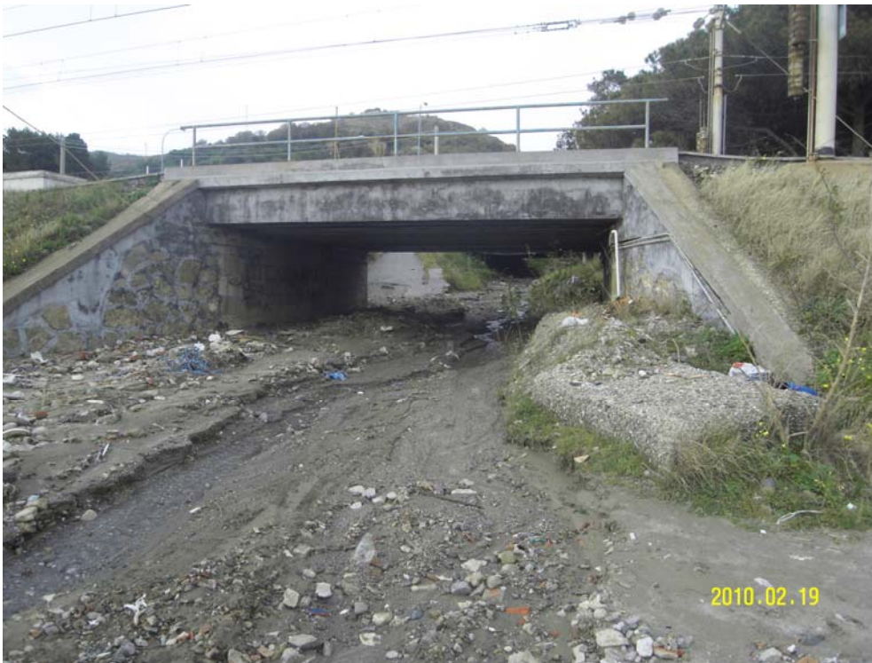
Fotografia dell'area di intervento 6
