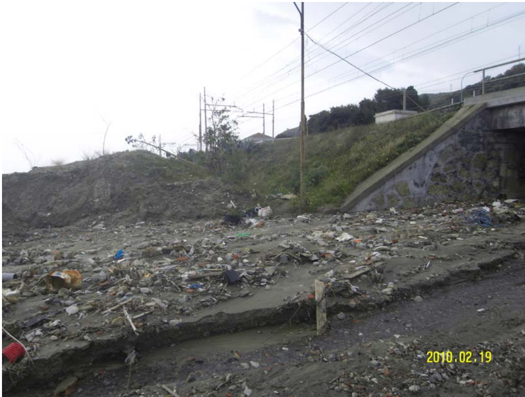
Fotografia dell'area di intervento 7
