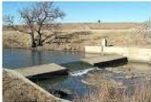
Soglie di fondo con passaggio per la profondità critica.
