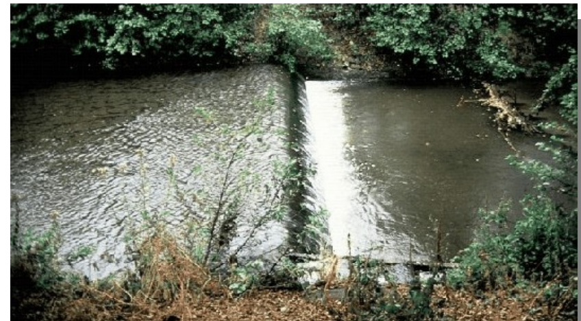
Fig. 6.16 - A sinistra, il profilo primitivo , precedente la realizzazione di briglie, grazie al deposito di materiale detritico, viene modificato (minore pendenza) e stabilizzato in corrispondenza degli apici degli sbarramenti ( profilo di compensazione ). Talora, per evitare costruzioni troppo elevate in altezza, si fa ricorso alle soglie (a destra), opere trasversali analoghe alle briglie, ma con da altezza più contenuta, costruite in modo da non sporgere dal fondo. Esse servono per creare dei punti fissi, inderodabili dalla corrente e, al contrario della briglia che lavora per accumulo di materiale, ottenere il raggiungimento della pendenza di compensazione tramite l'erosione del materiale a valle delle stesse, creando ugualmente una successione di salti raccordati tra loro da livellette a pendenza contenuta.
