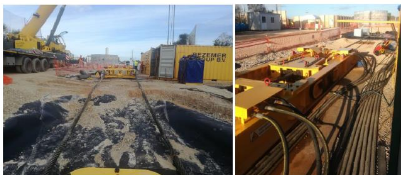
Figura 6 – Attrezzature per l'attività di tiro della condotta su aree impermeabilizzata
