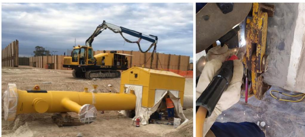
Figura 4 – Saldatura del piatto di prova con la condotta offshore per collaudo idraulico
