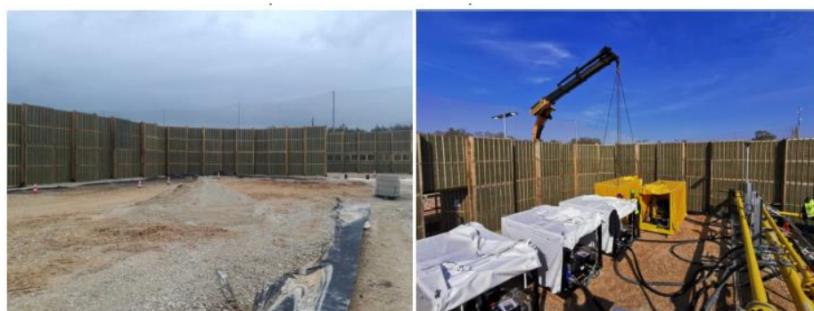
Figura 5 – Attrezzature per attività di collaudo idraulico su aree impermeabilizzate
