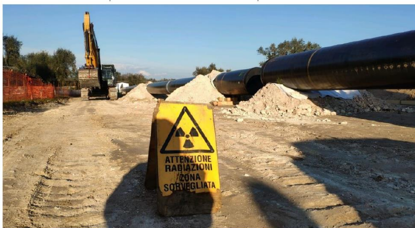
Figura 2 - Segnalazione indicante il tipo di zona durante l'esecuzione del controllo delle saldature
