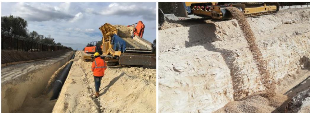
Figura 2 – Operazioni di rinfianco con vibrovaglio (sinistra) e di rinterro con vibrovaglio (destra)
