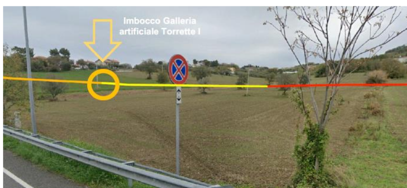
Figura 18 – Vista da via F. Giuseppe, in direzione del tratto in uscita dall'imbocco Ovest della Galleria artificiale Torrette I (in arancione la proiezione al suolo del tracciato in galleria, in giallo del tratto in trincea, in rosso del tratto in rilevato)
