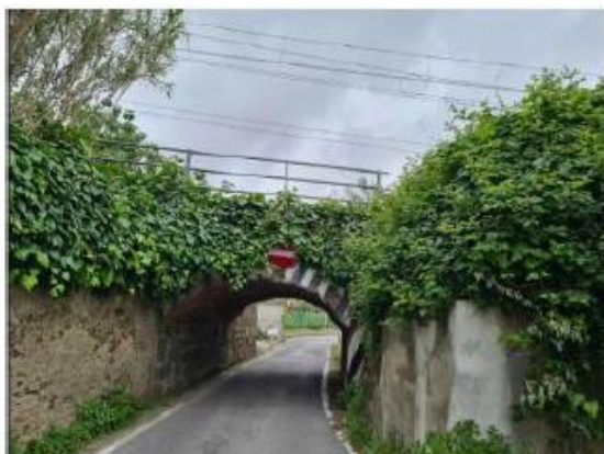
Figura 9 – Ponticello in muratura sottobinario
