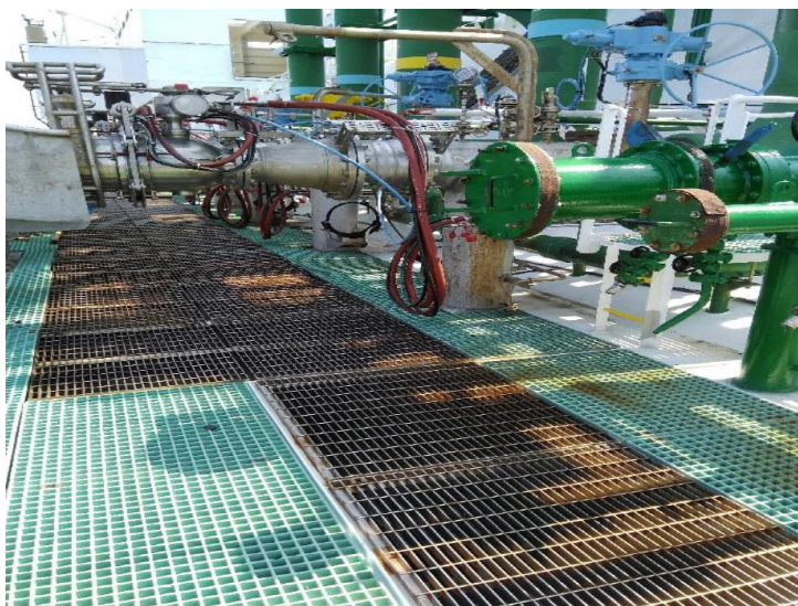
Ghiotta per sistema dell'olio idraulico di azionamento del sistema di sezionamento delle manichette di trasferimento del GNL (punto 4.a)
