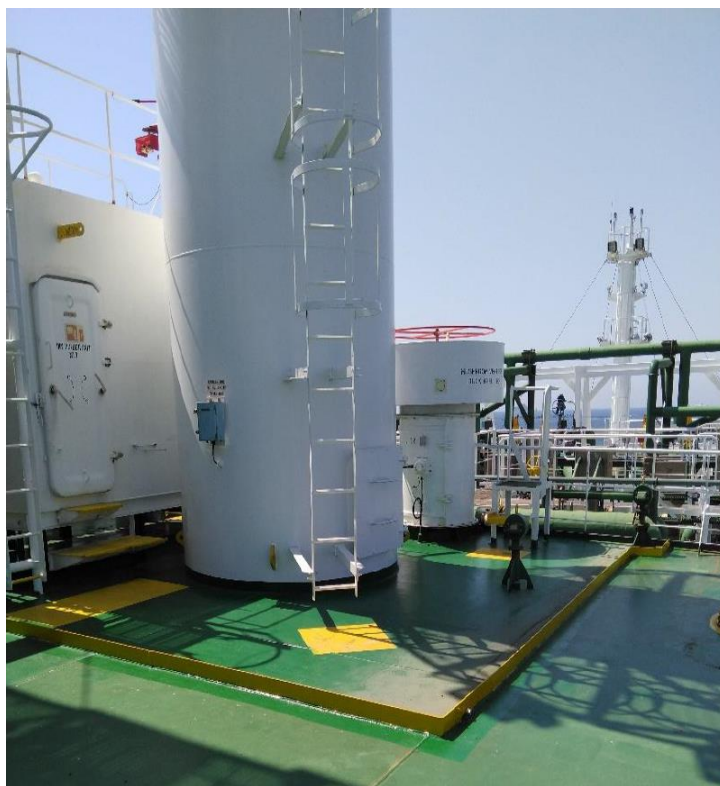
Area impermeabile e cordolata con tappo al di sotto di gru a piedistallo (punto 4.b)
