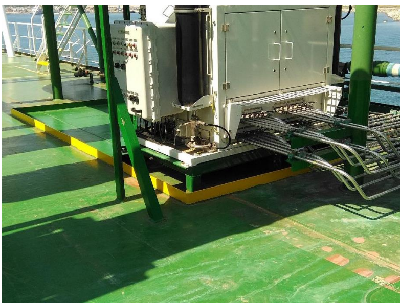
Area impermeabile e cordolata con tappo al di sotto della centralina olio idraulico (punto 4.a)
