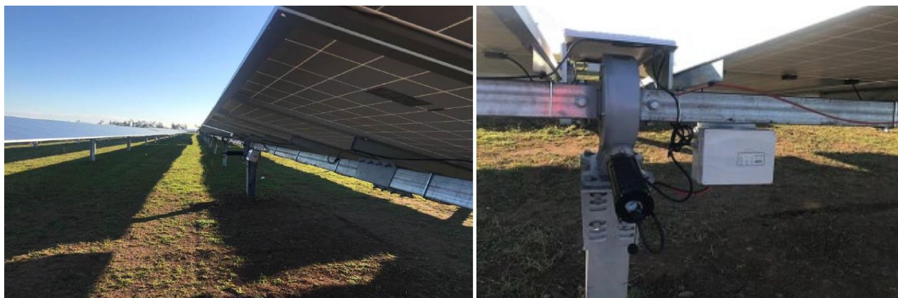
Figura 3 - Struttura dell’inseguitore monoassiale tipo
