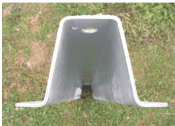
("Fondamenta") Profilo in acciaio conficcato nel terreno.
