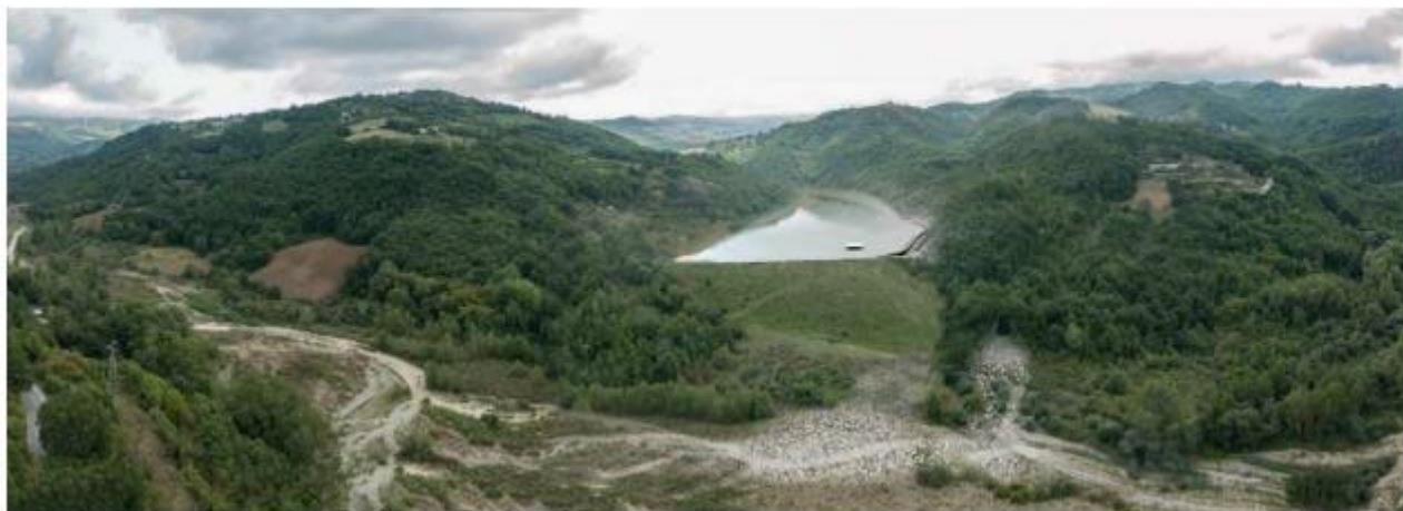
Figura 51: Stato di progetto dell'invaso di valle con le opere annesse (vista dal recettore I). La centrale non si percepisce grazie alle misure di mitigazione previste. il paramento della diga rinverdito presenta pendenze dolci. Lo scarico sarà inserito nel versante esistente e si noterà solamente lo sbocco nella fiumara. (cfr. PD-VI.2_SIA. Pag. 310 fig. 167).
