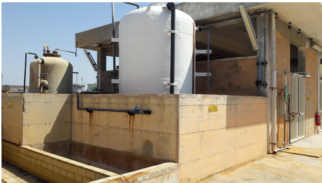
Immagine 1 – Unità DFTA: serbatoio di stoccaggio Clorito di sodio e bacino di contenimento
