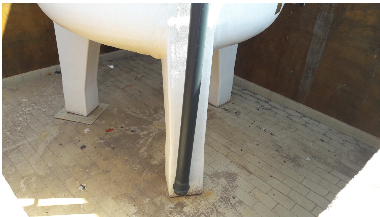
Immagine 2 - Unità DFTA: serbatoio di stoccaggio Clorito di sodio: particolare pavimentazione
