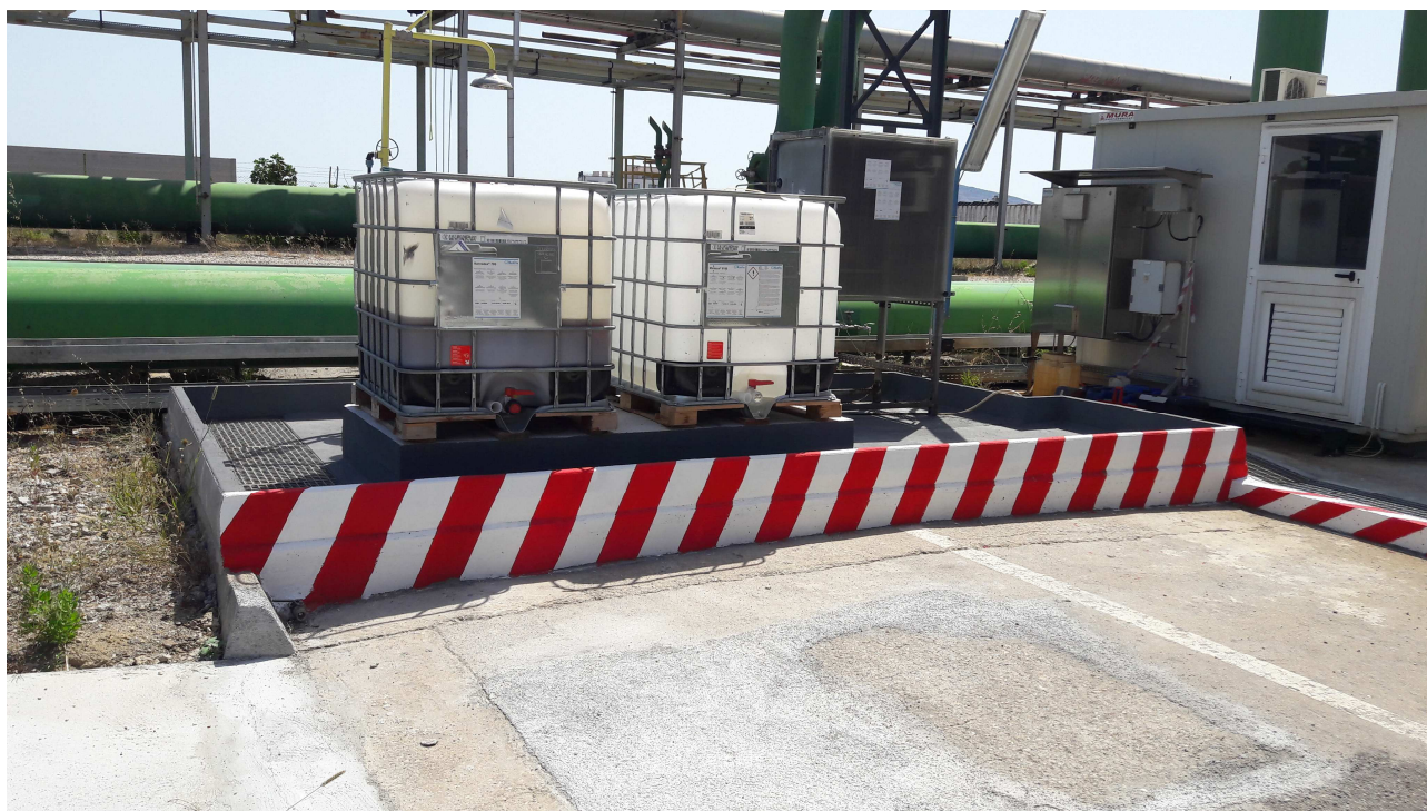
Immagine 3 - Unità DFTA: cisterne di stoccaggio Cetamine F310 e FERROCID 5280-S e relativo bacino di contenimento
