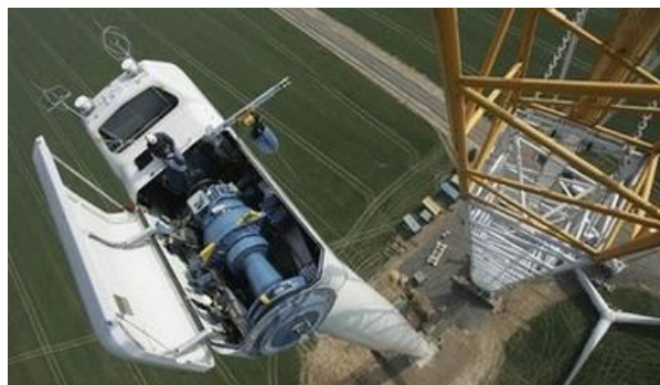
Navicella in fase di installazione
