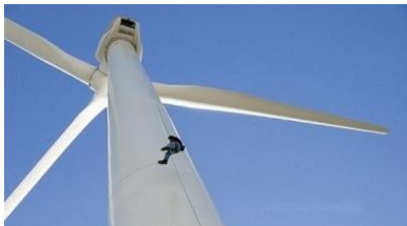
Torre tubolare in acciaio
