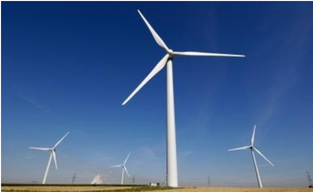
Generatori eolici con rotore tripala
